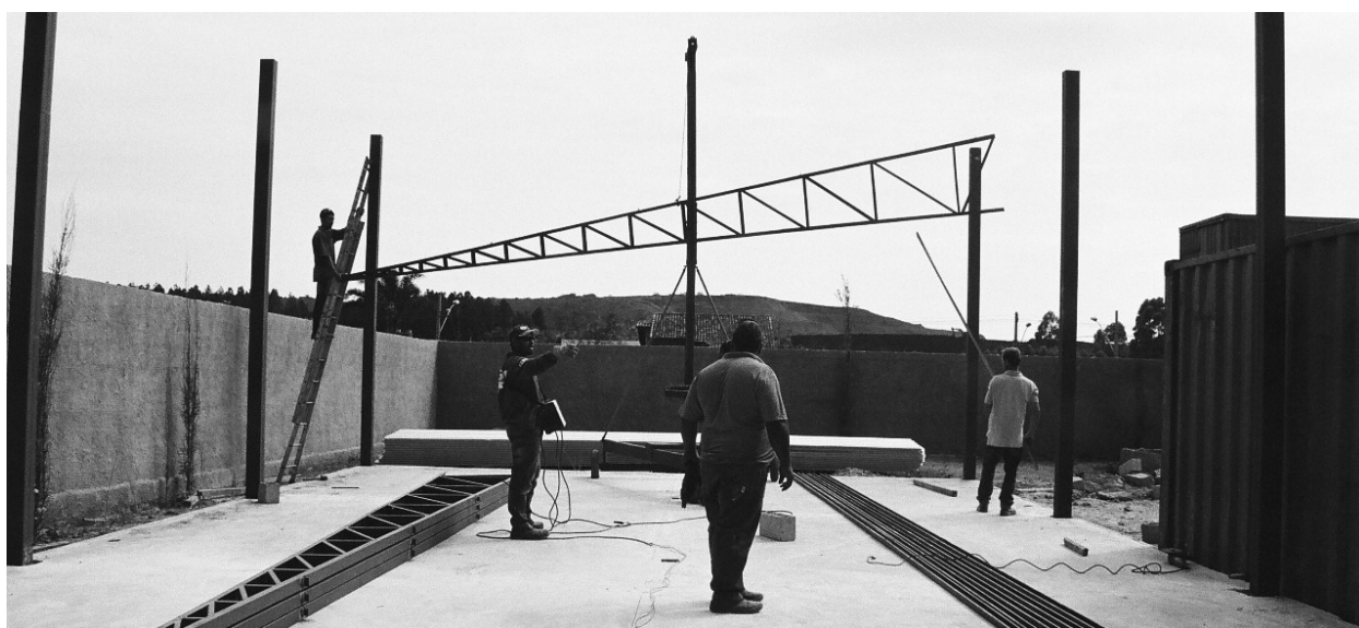
Construção da sede do Ja.Ca, Belo Horizonte (Brasil) © Maura Grimaldi, 2014
